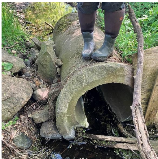
Figur 9: Eksisterende rørbro med tidligere interimistiske opstemnings plader
