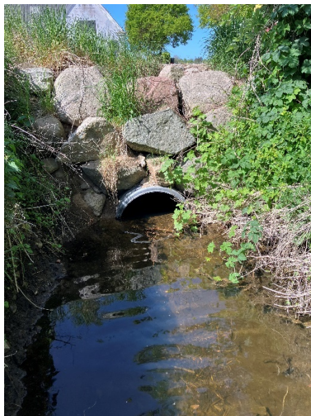
Figur 4-1: Eksisterende rørudløb i Ejlsmoserenden med tilhørende stensikring.
