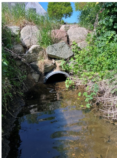
Figur 4-1: Eksisterende rørudløb i Ejlsmoserenden med tilhørende stensikring.
