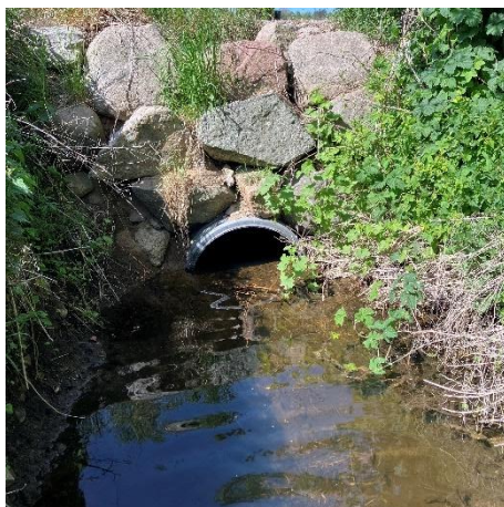
Figur 4: Eksisterende rørudløb i Ejlsmoserenden med tilhørendestensikring.
