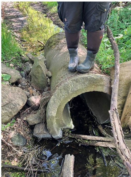
Figur 4-6: Eksisterende rørbro med tidligere interimistiske opstemnings plader.
